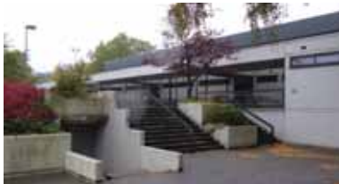
Sporthalle Brackweder Gymnasium · Beckumer Straße
